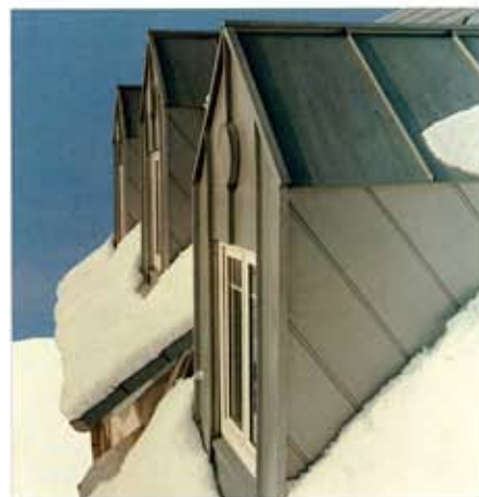
Dachgauben mit Winkelstehfalz und Steckfalz
